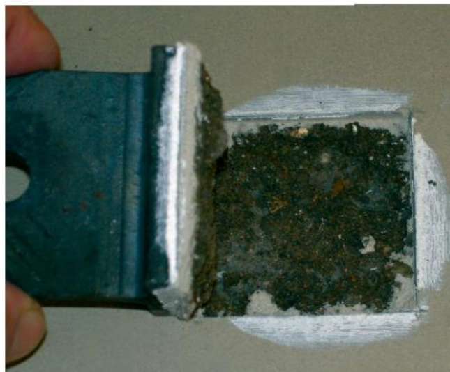
Skúšobné razítko v ťahu na spevnených a vystierkovaných cementových poteroch.
